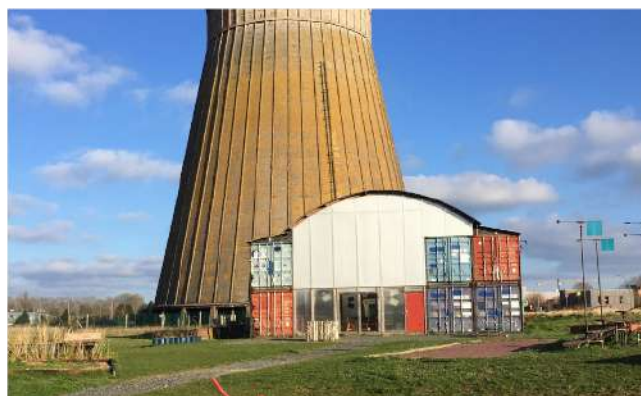
Photo Cité de chantier en matériaux de réemploi
