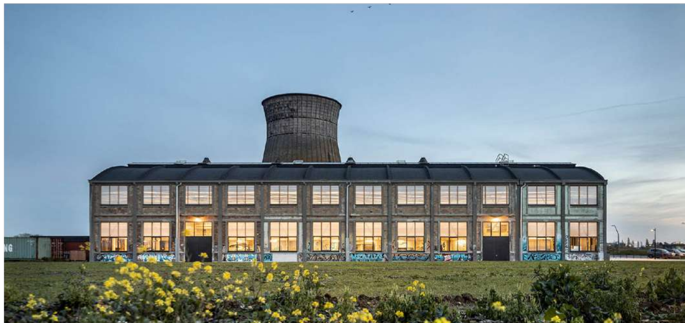
Photo extérieure de la grande Halle , crédit Encore Heureux
